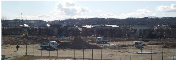
校庭工事(23日) 水はけ改良のための暗渠(あんきょ)埋設。
