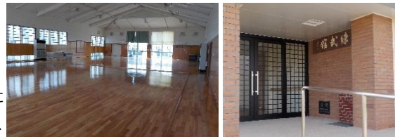
練習館大規模改造工事竣工(27日) エアコン設置の他、外部、内部、電気、機械、全ての面で新しくなりました。工事関係者及び町当局の皆様へ深く感謝申し上げます。
